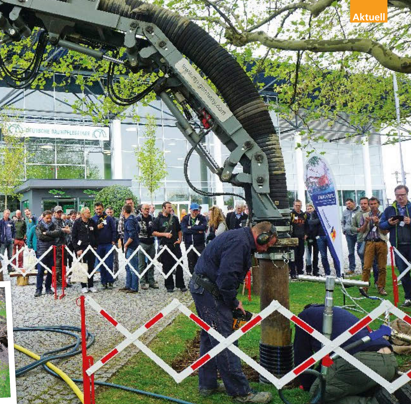
Die Vorführung eines Erdsaugers zeigte die Vorteile einer schonenden Wurzelbehandlung.
